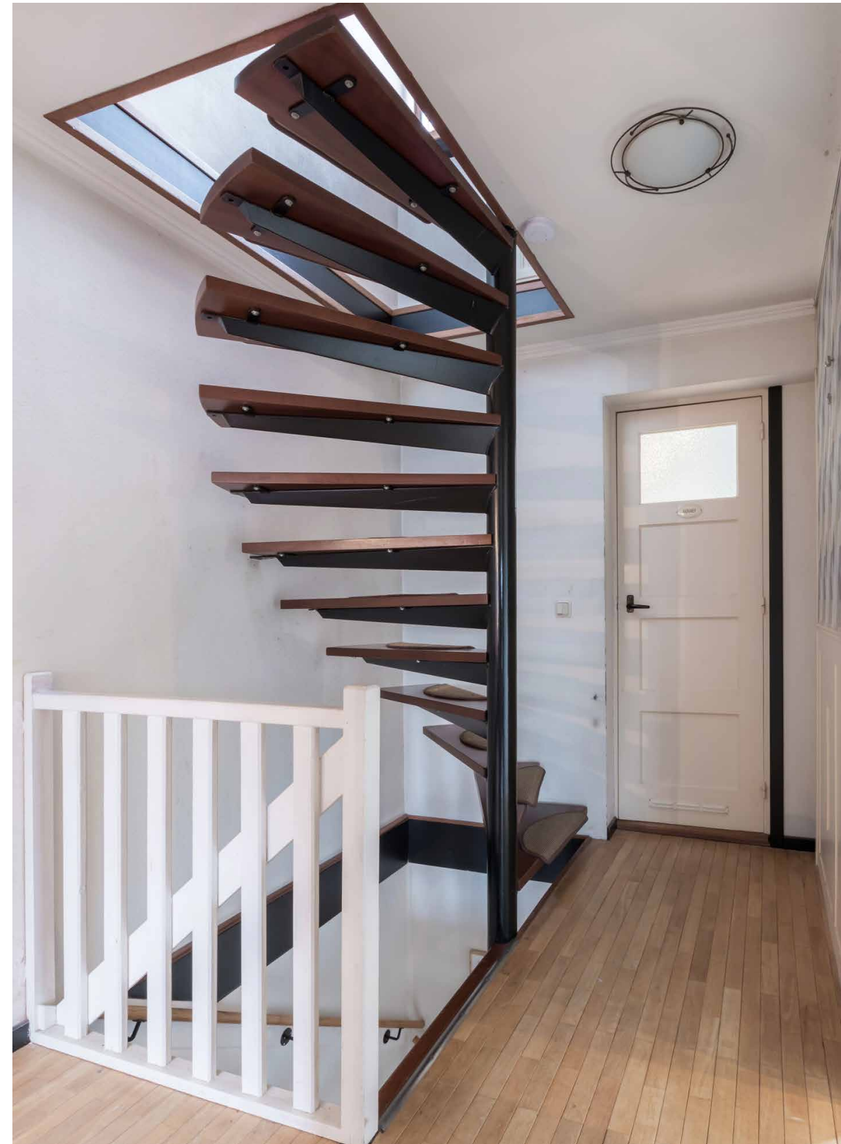
Overloop 1e verdieping met trapopgang naar zolder.
